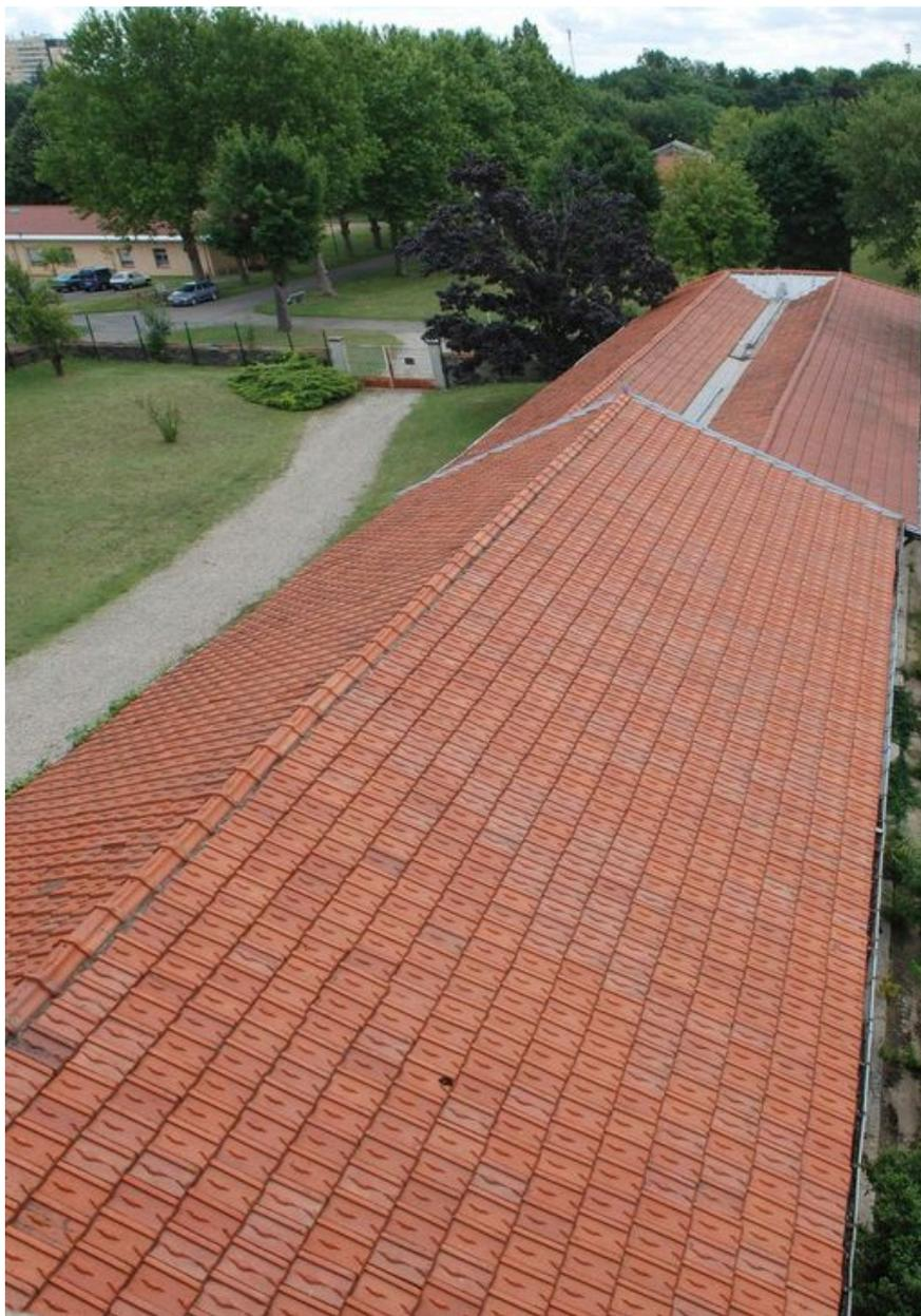
Toit en tuiles mécaniques du promenoir depuis le premier étage du bâtiment : les deux petits toits à double pente sont d'origine, le toit à double pente du premier plan correspond à la modification de la première partie du promenoir en salle fermée
