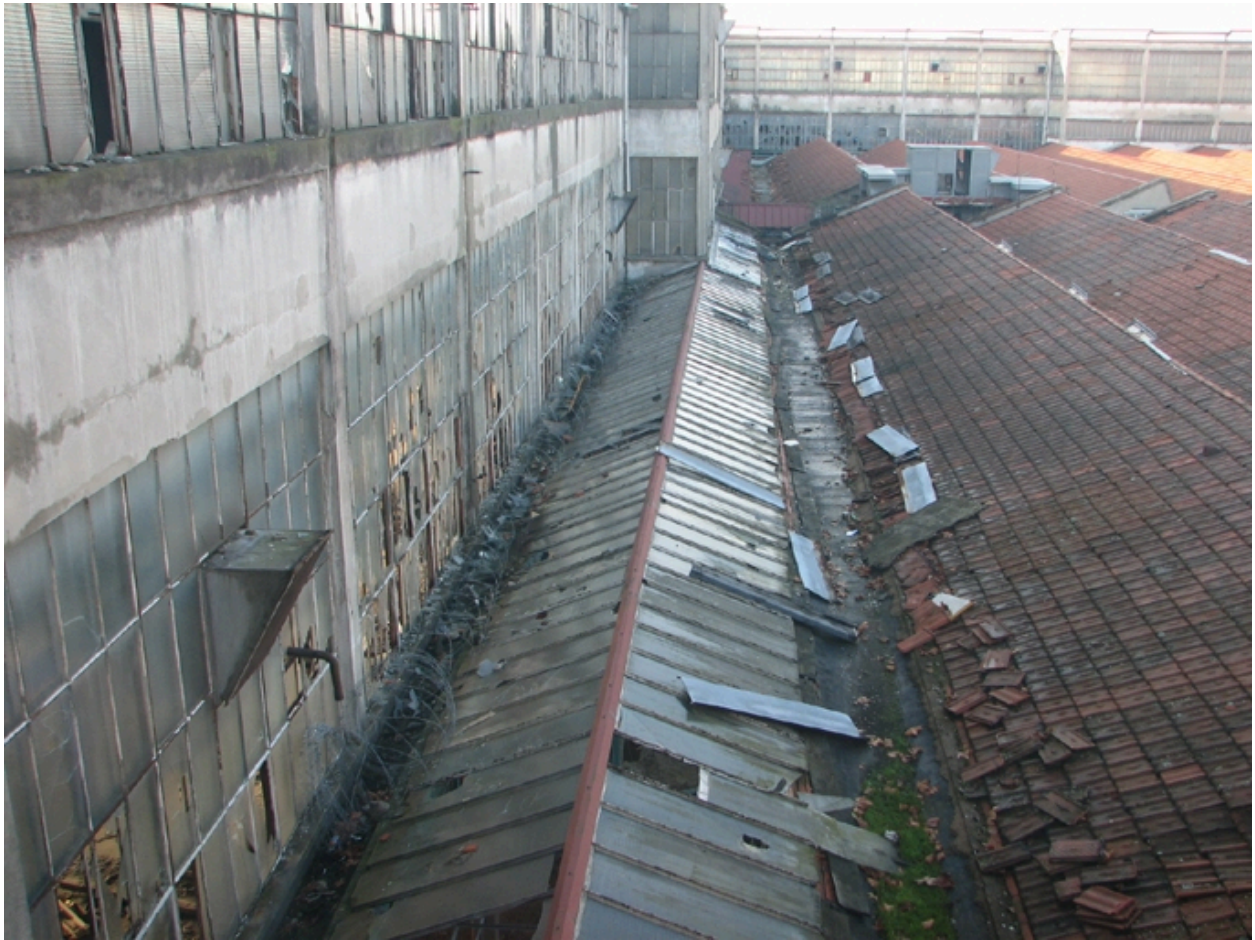
Détail toiture nord-ouest éclairage zénital
