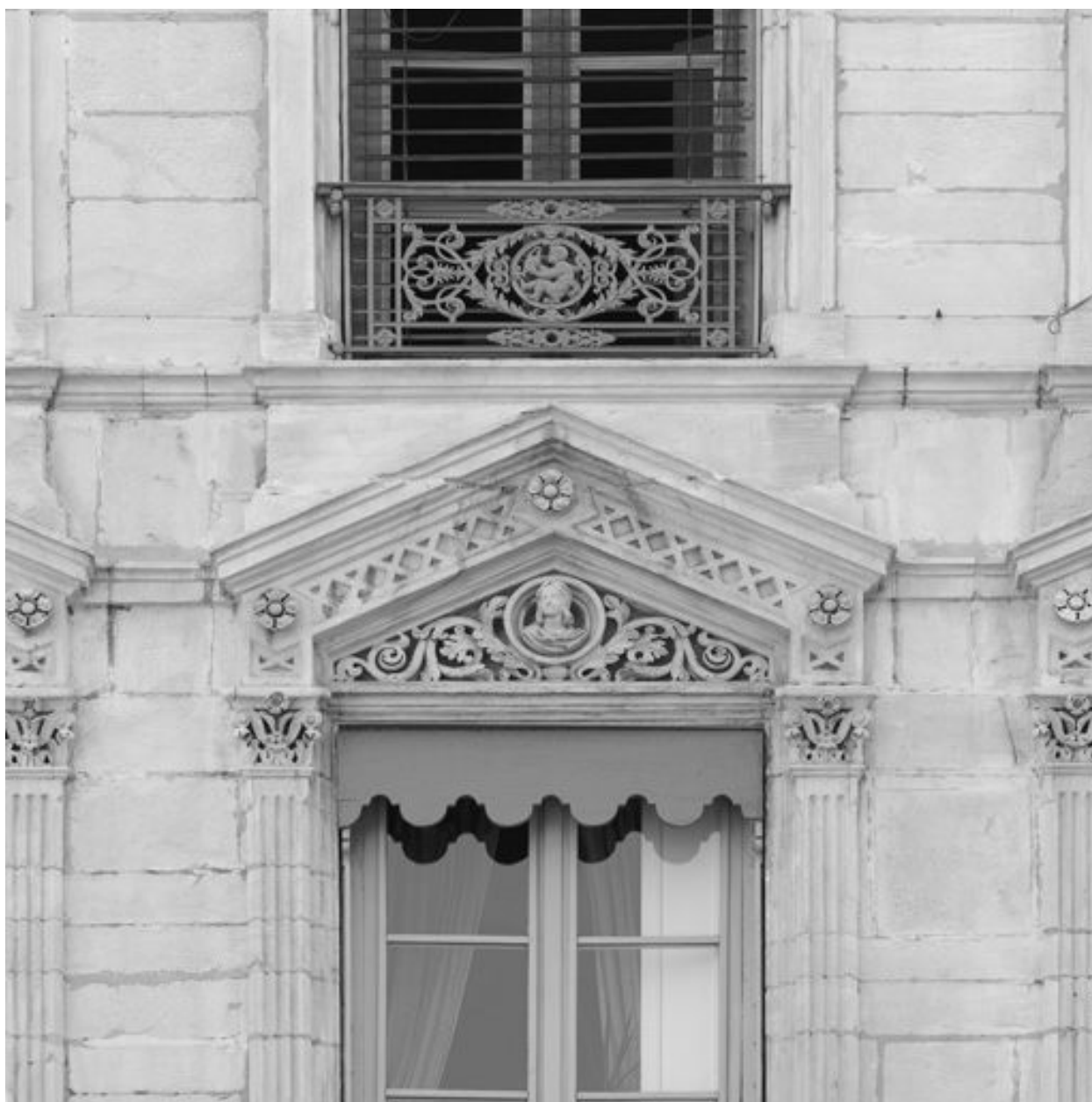
Elévation quai Saint-Antoine, deuxième travée à partir de la gauche : fronton sculpté du premier étage carré et garde-corps du second
