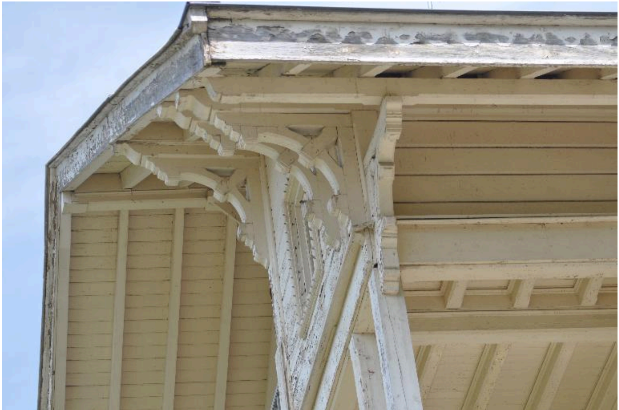
Aisseliers en bois sous l'avant-toit
