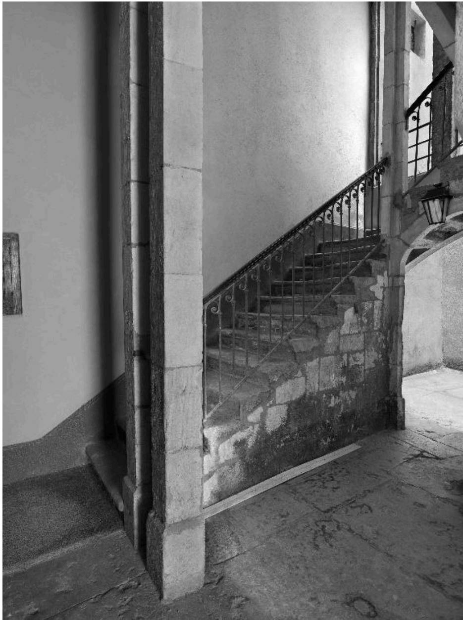
L'escalier nord : départ
