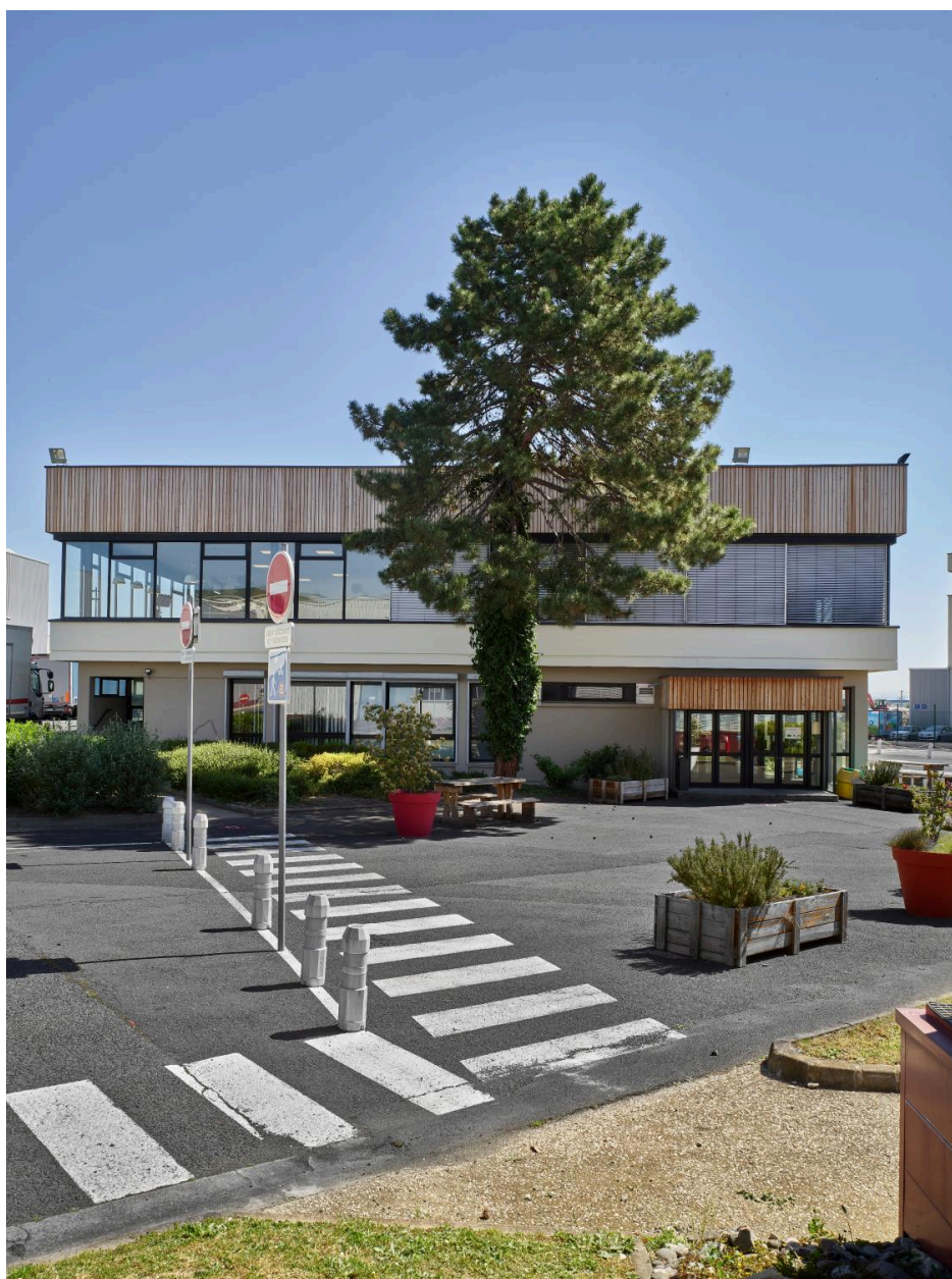
Le restaurant d'entreprise S60, depuis l'ouest.
