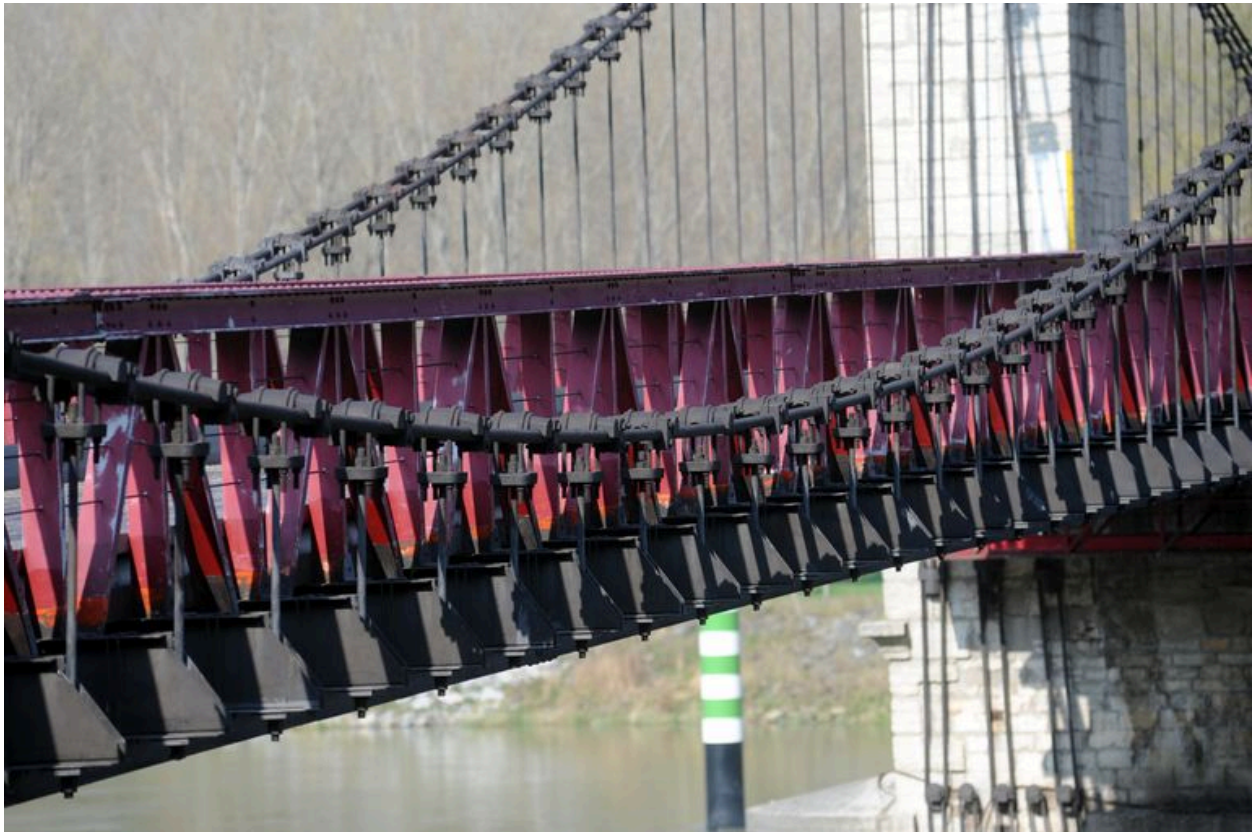
Travée centrale, de côté, face aval, vue partielle : jonction entre les suspentes et le tablier, parapet (depuis la rive droite)
