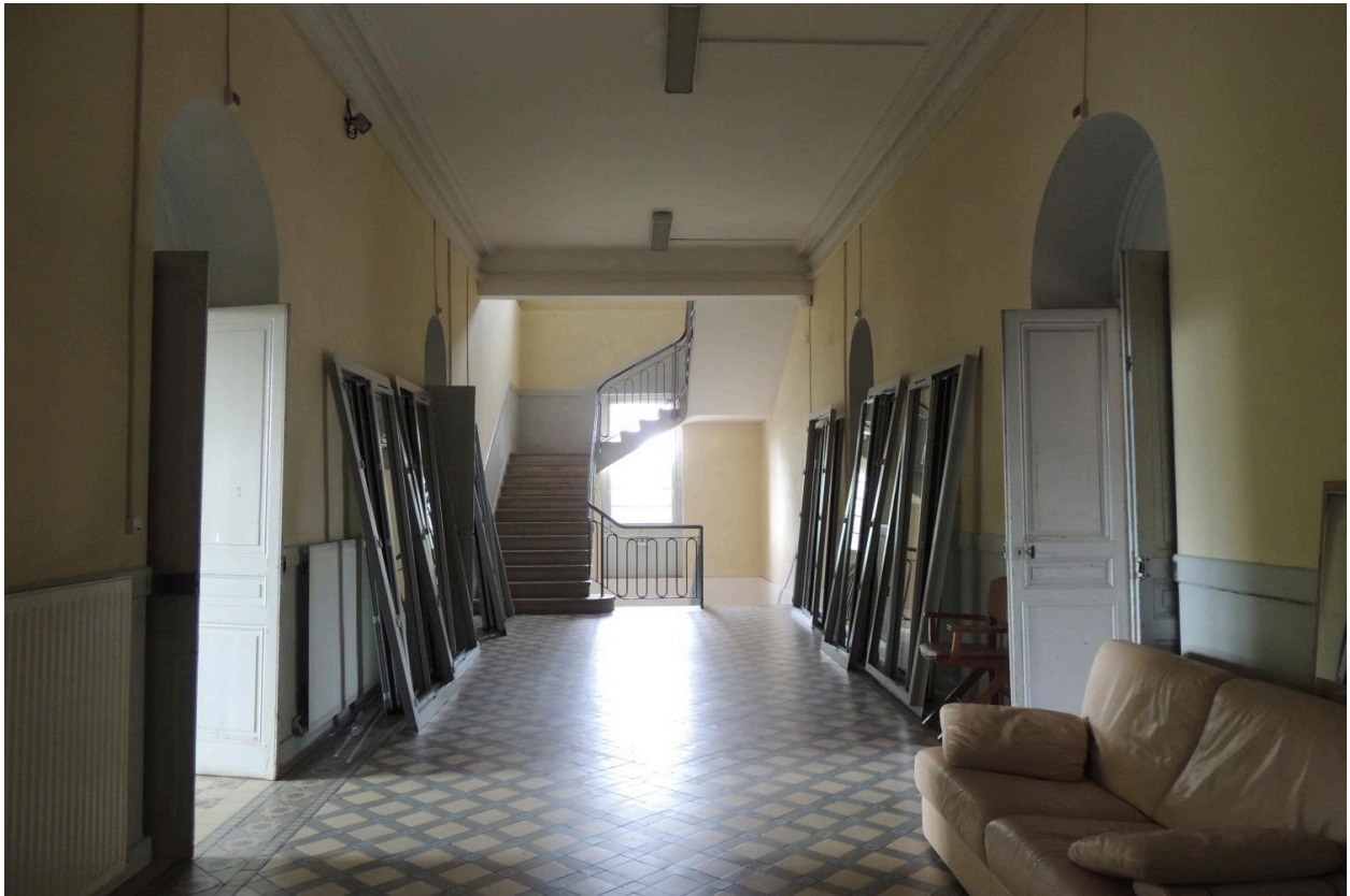
Premier étage, vue vers le nord.
