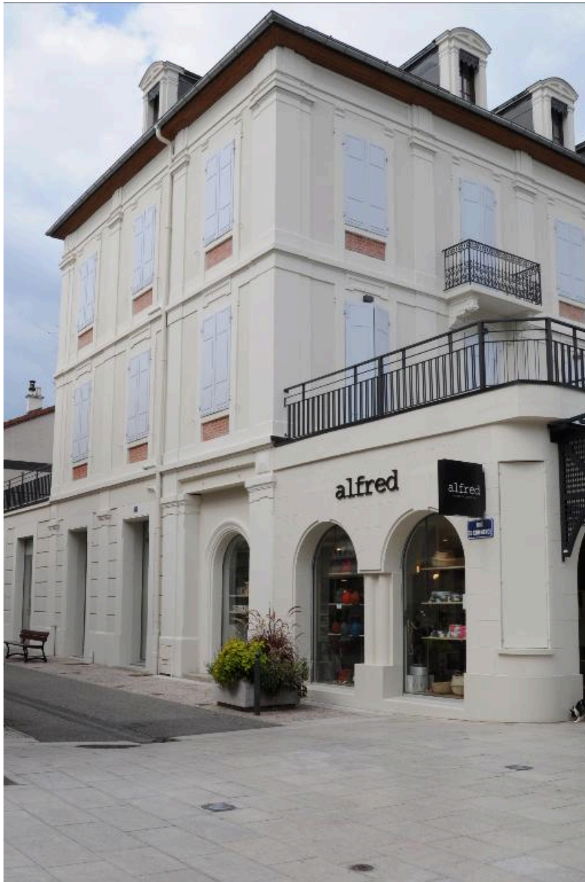
Élévation latérale, vue de trois-quart depuis le sud-est
