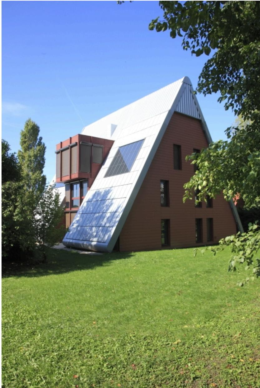
Bâtiment des appartements de fonction, à l'ouest du lycée. L'immeuble est construit selon le même principe de la cuve support de structure, sur laquelle est fixée une poutre tridimensionnelle supportant l'ensemble par suspension.
