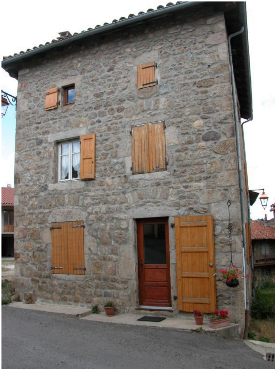
Maison (1986 AH 142), élévation logis sur mur pignon.
