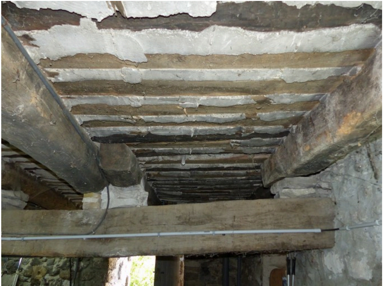
Etage de soubassement, étable. Plafond.
