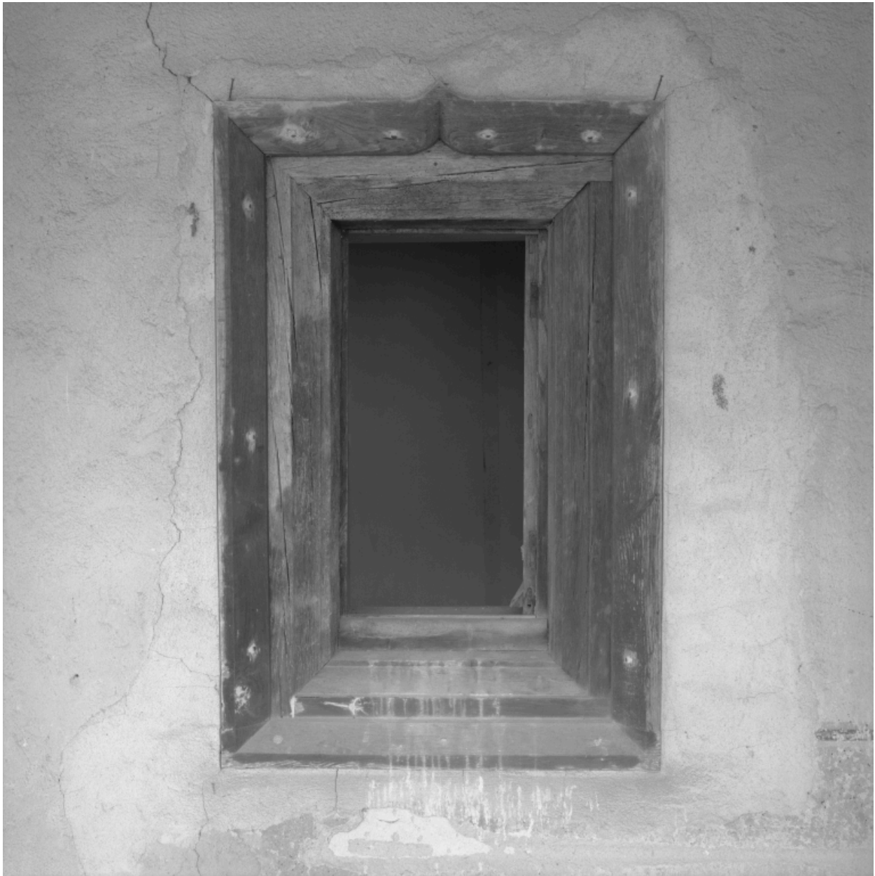
Détail de la baie d'une chambre du 2e logis.
