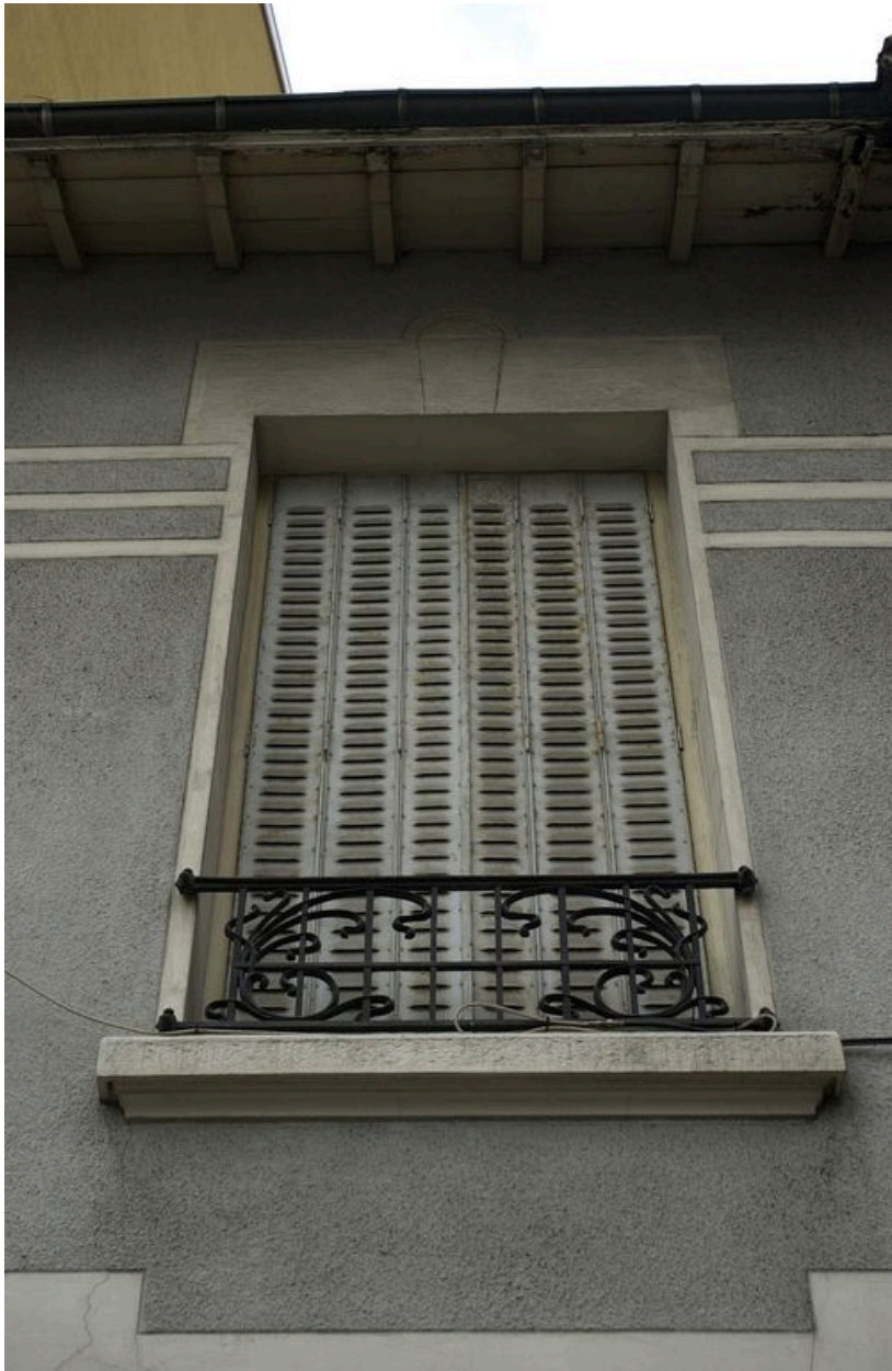
Façade sur rue, détail d'une fenêtre du premier étage
