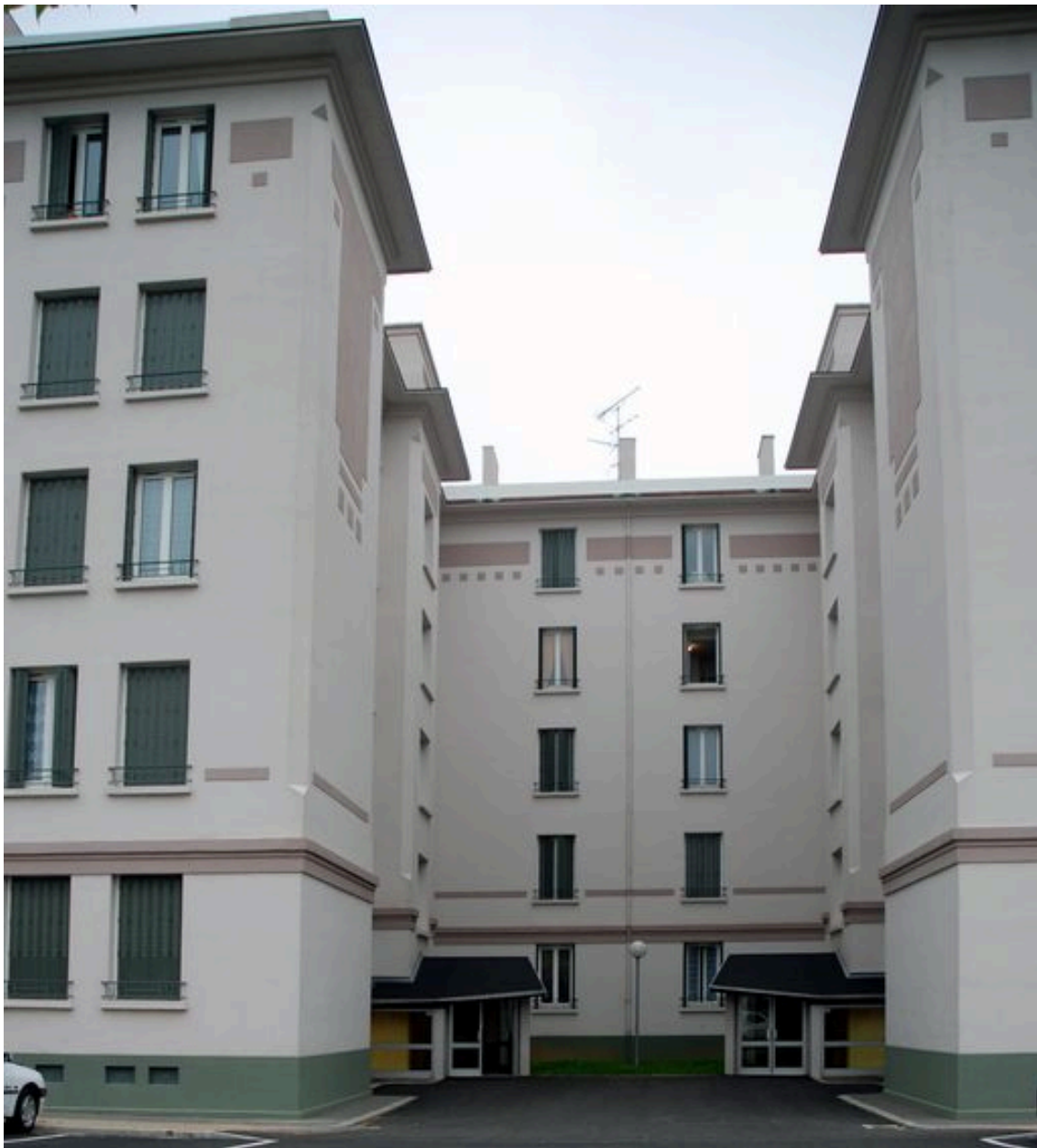
Vue resserrée de la façade depuis le sud-ouest
