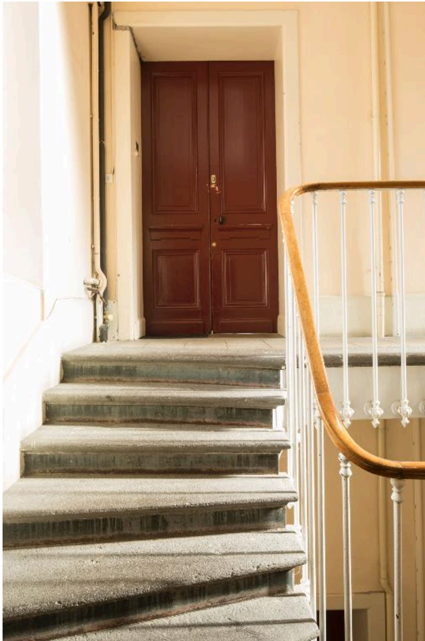
Bâtiment E. Logements de fonction. Escalier
