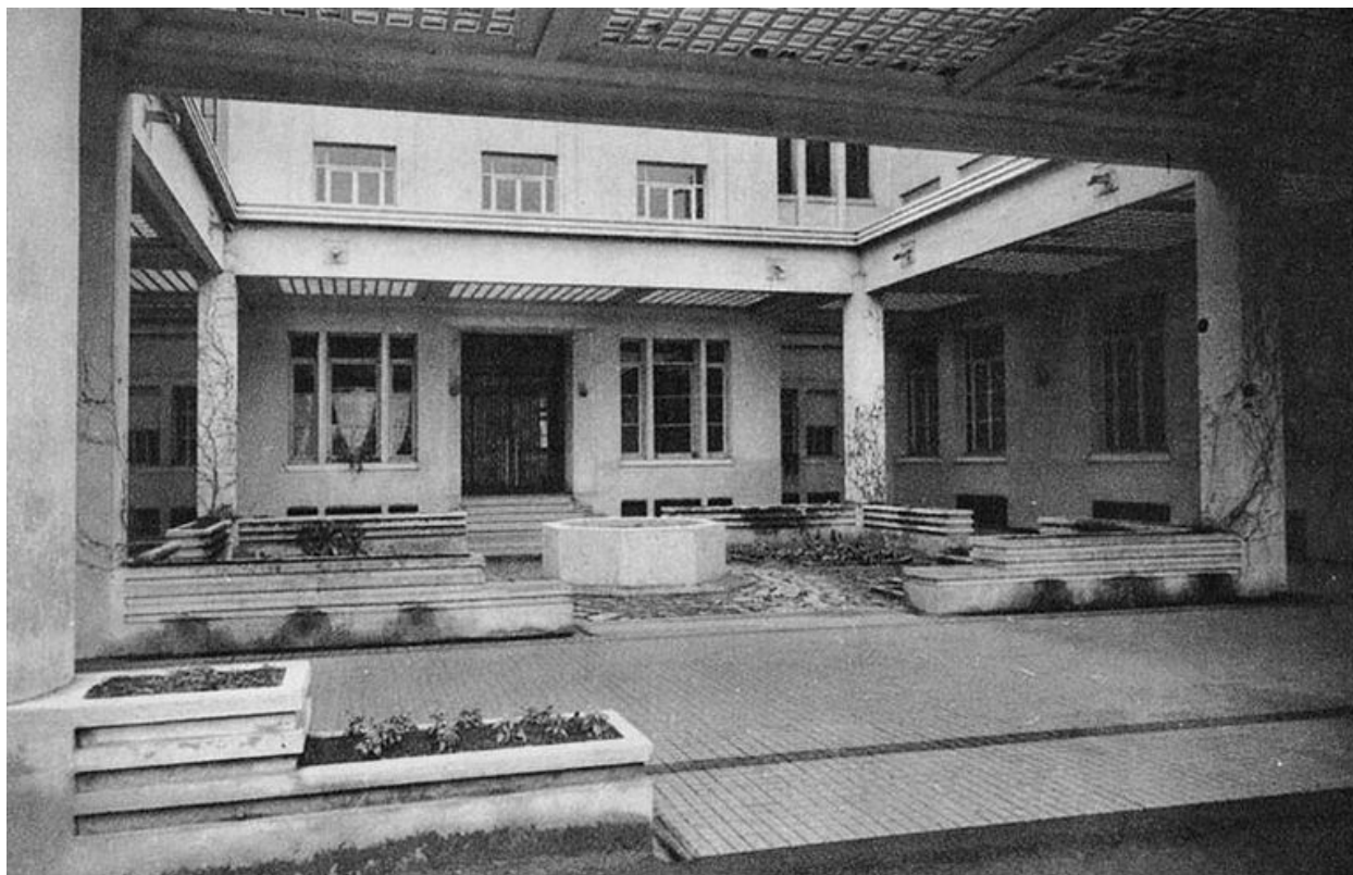
La cour d'Entrée
