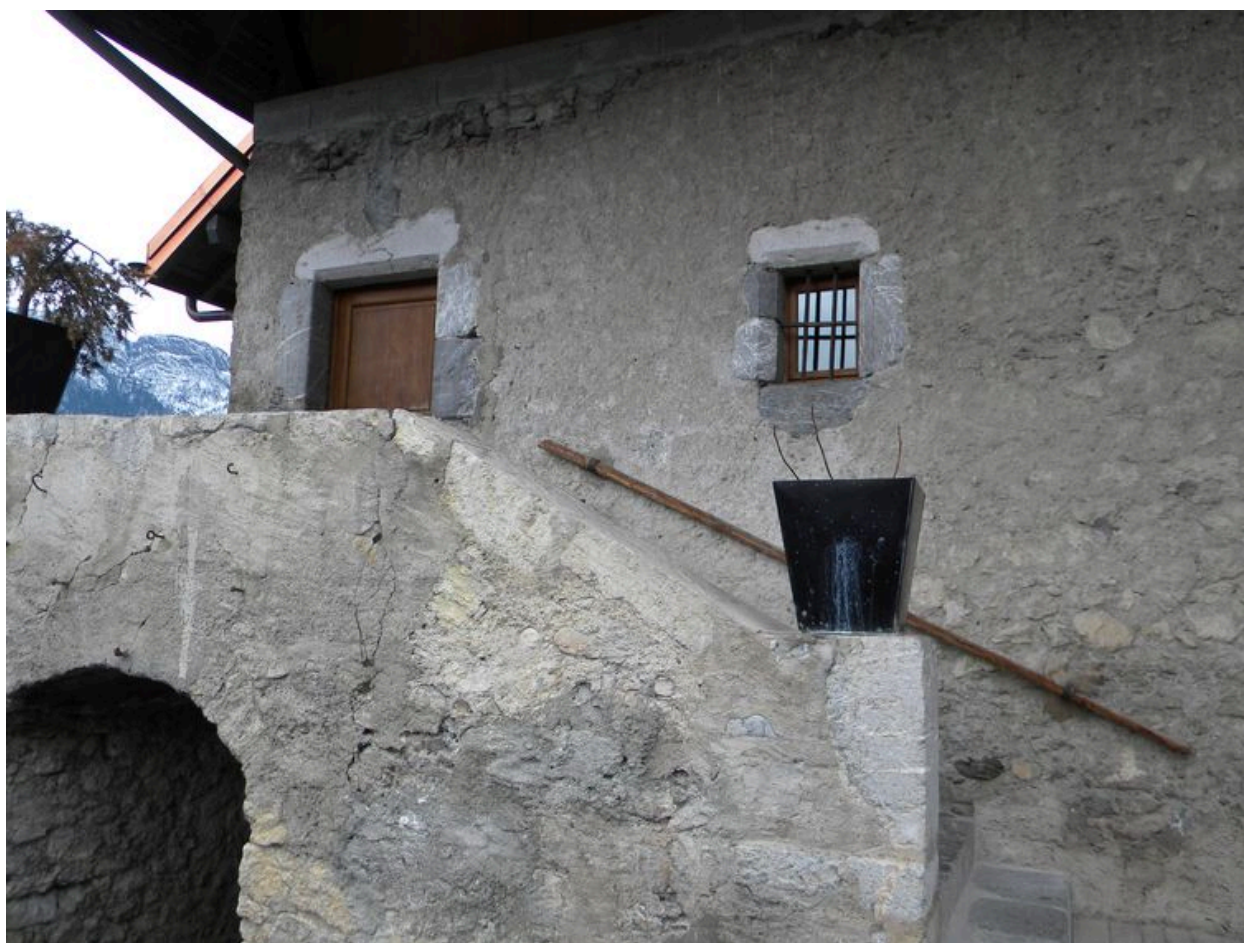
Escalier en façade principale et entrée de l'habitation.
