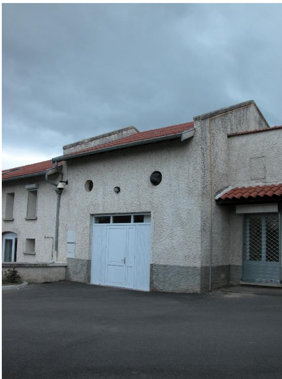
Vue d'ensemble de la remise située dans l'aile nord.
