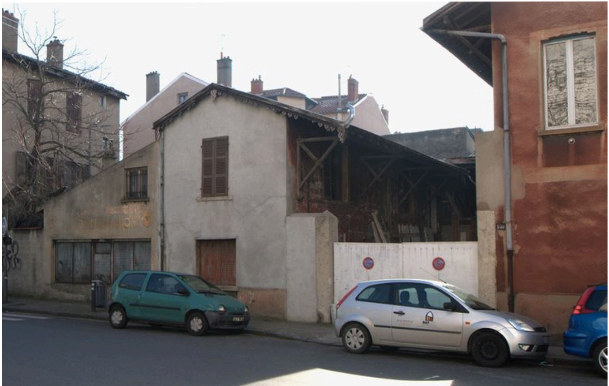
Elévation antérieure du 152 route de Genas depuis le nord-ouest
