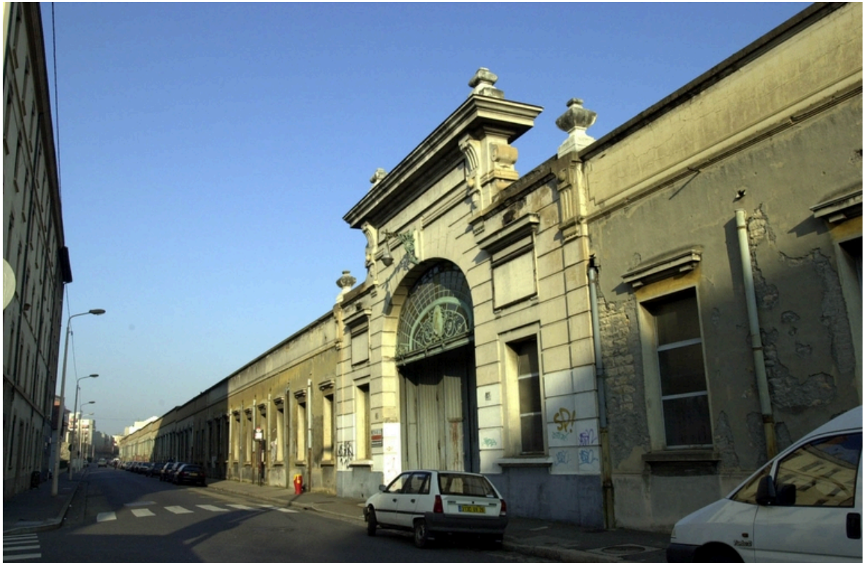
Entrée principale, vue ouest
