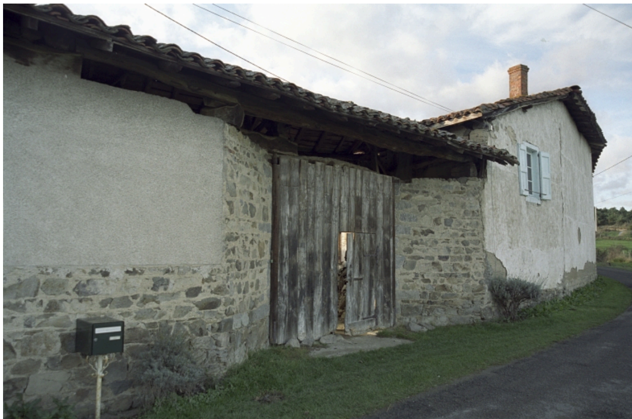
Vue d'ensemble depuis le chemin : passage couvert.
