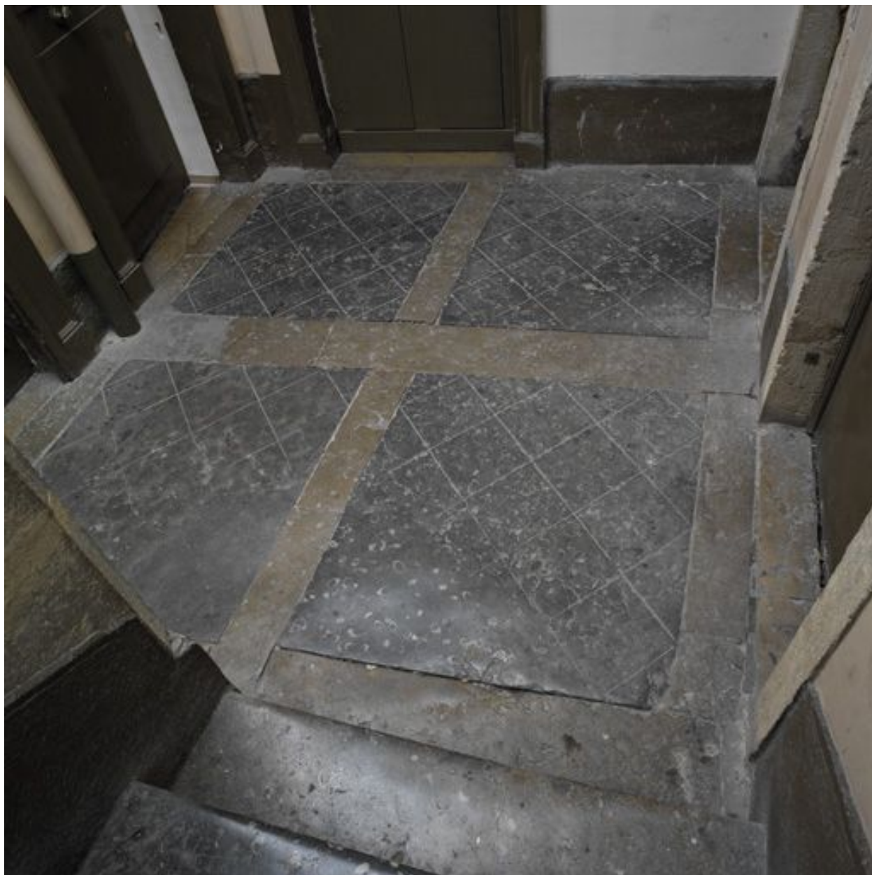
Escalier, sol du palier du 1er étage
