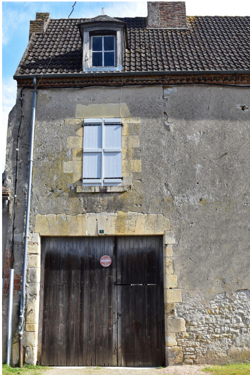
Maison, 12, rue d'Allier, parcelle cadastrale B01 : 1132. Vue d'une travée de la façade sur rue, en élévation : porte cochère, fenêtre et lucarne, limite du 18e siècle et 19e siècle.
