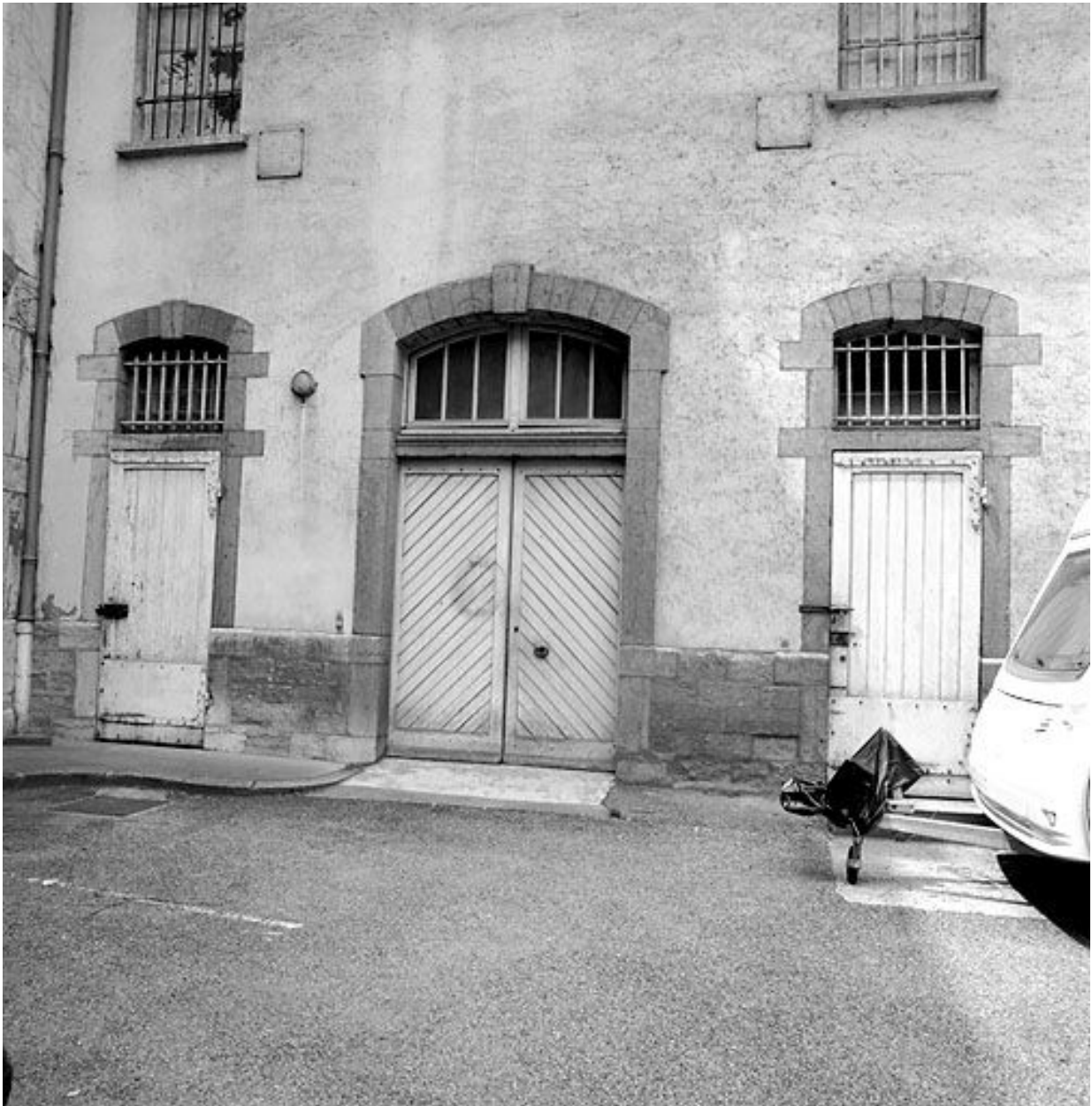
Dépendances situées à l'ouest : détail des portes
