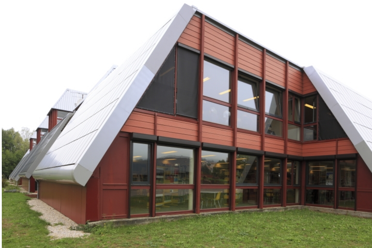
Bâtiment F, façade sud-est, les panneaux solaires sur plans inclinés à 60°, après les travaux de réhabilitation. Au rez-de-chaussée, le CDI.
