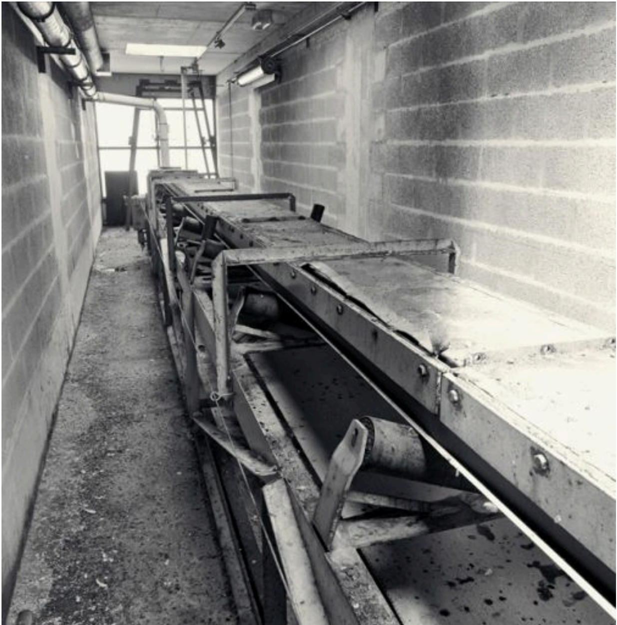
Intérieur des silos, la galerie supérieure : vue du transporteur à bande
