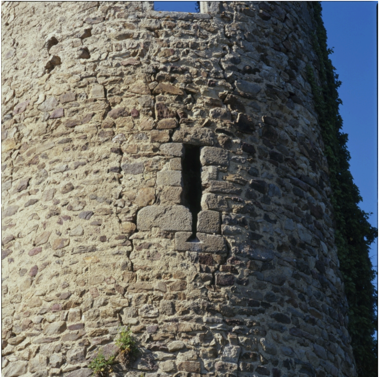
Première enceinte, angle nord, tour ronde (tour n°10 du plan), premier niveau : vue extérieure de l'archère d'angle à étrier, du nord.
