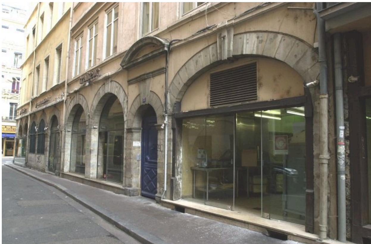
Façade, 1er niveau
