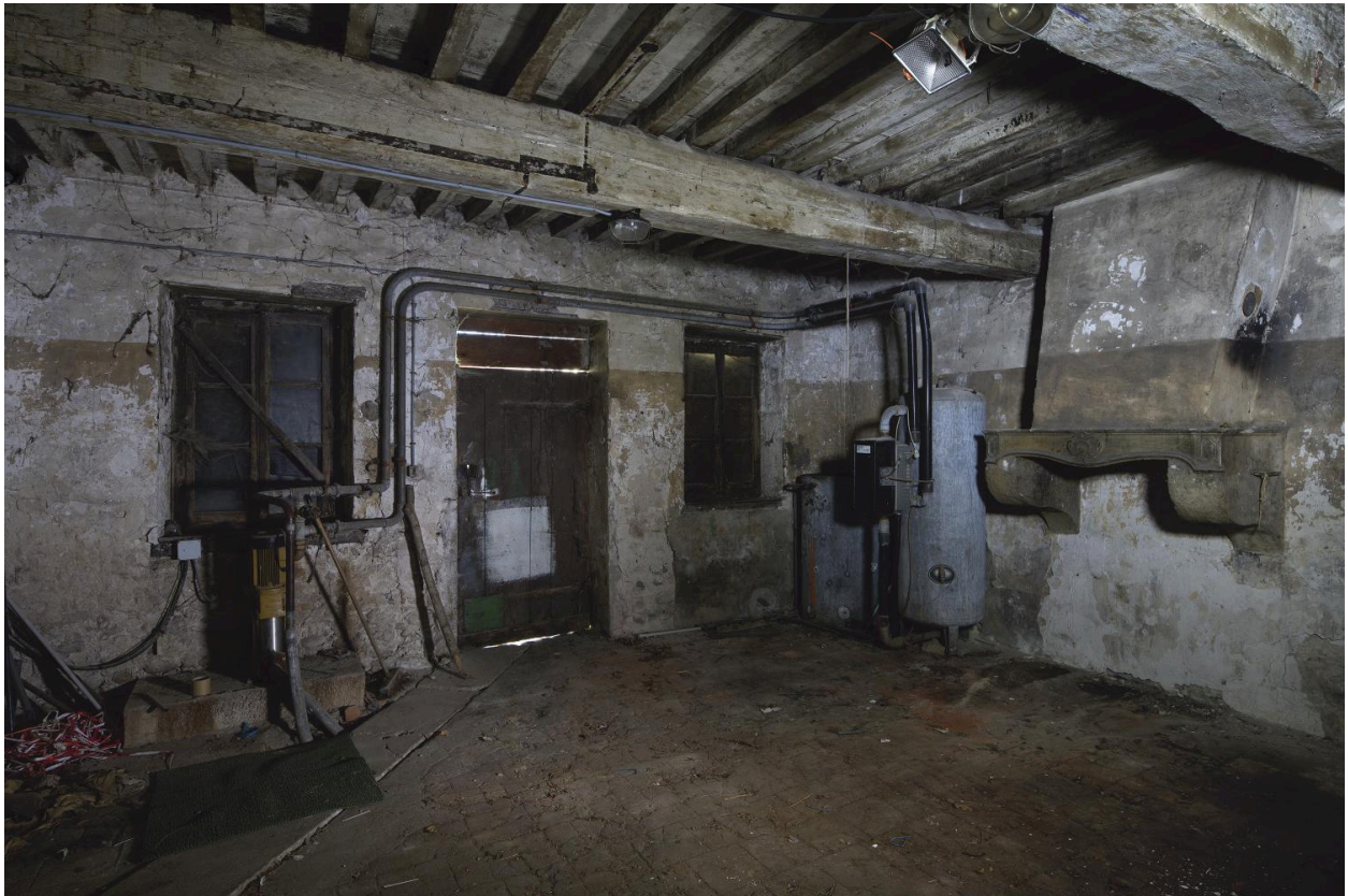
Maison du jardinier, vue intérieure
