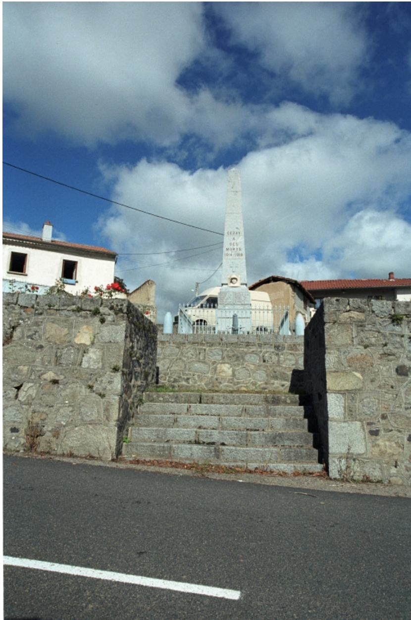
Vue d'ensemble de face, depuis la route.
