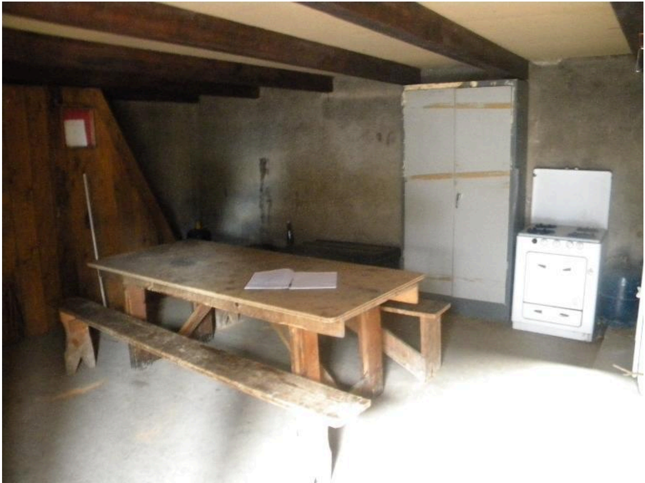
Vue de l'intérieur du bâtiment nord.
