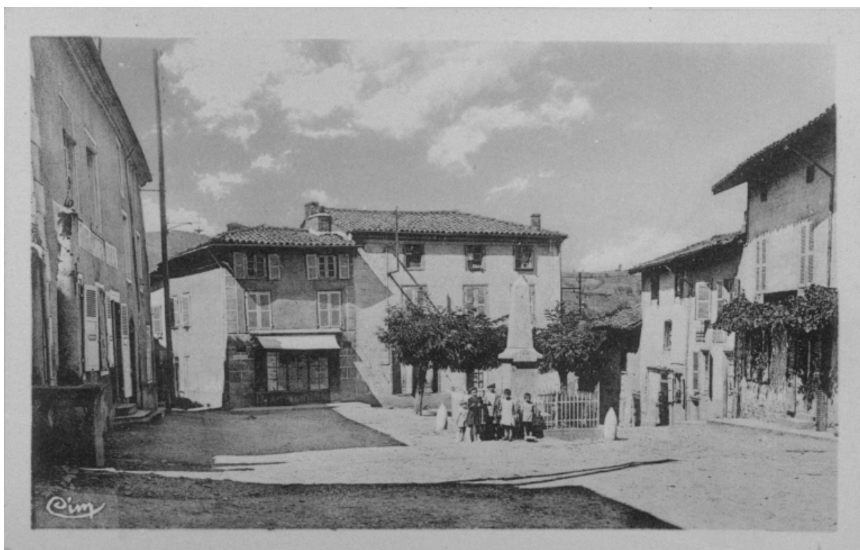
L'HOPITAL-sous-ROCHEFORT (Loire) / La Place et le Monument aux Morts. COMBIER IMP. MACON. CIM.
