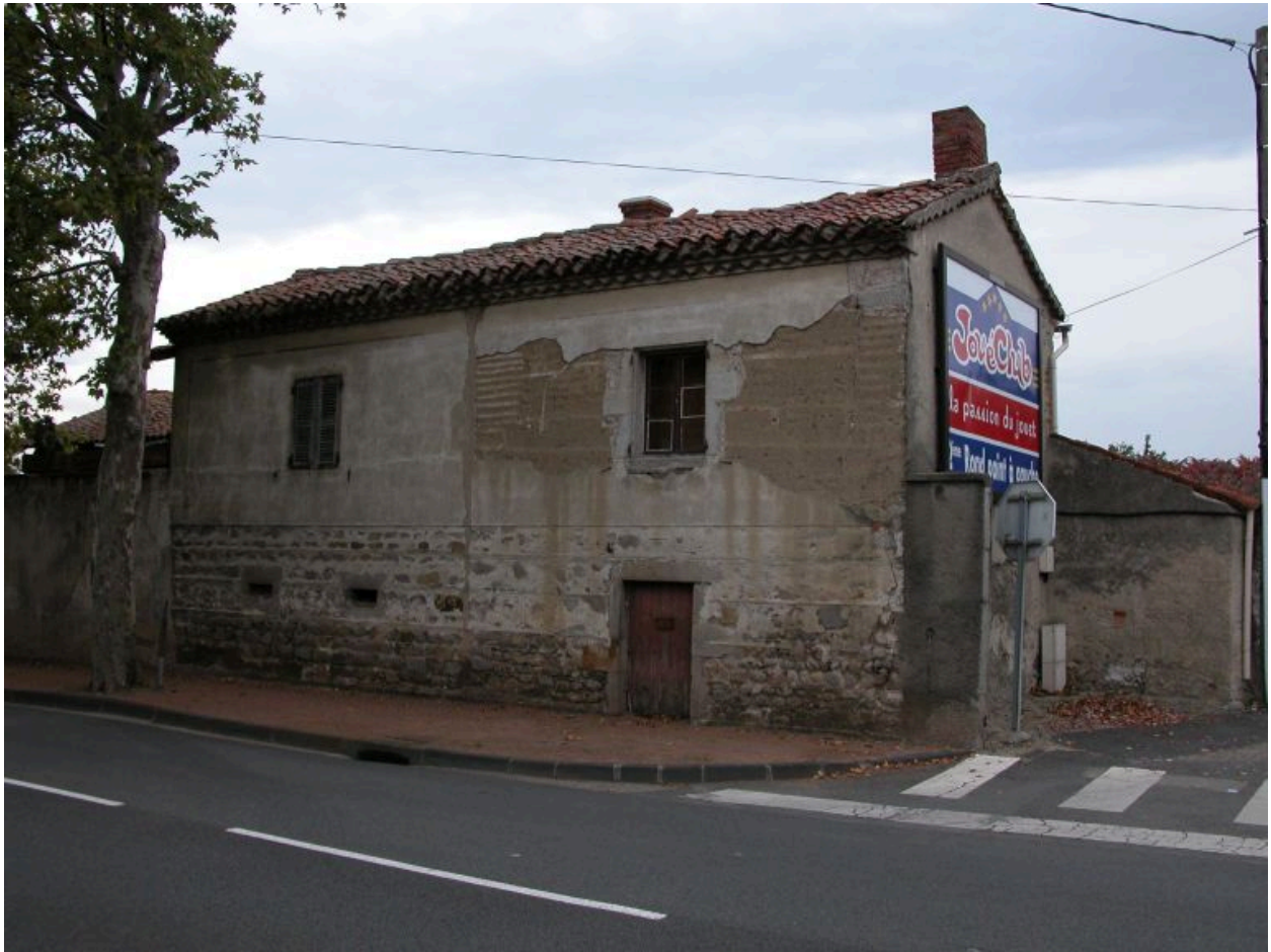
Vue d'ensemble de la façade nord du logis depuis l'avenue.
