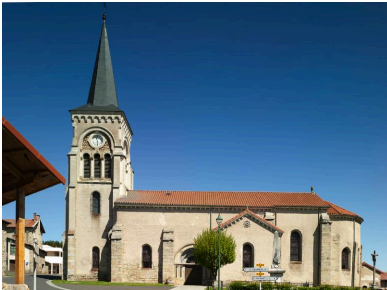
vue générale de l'église
