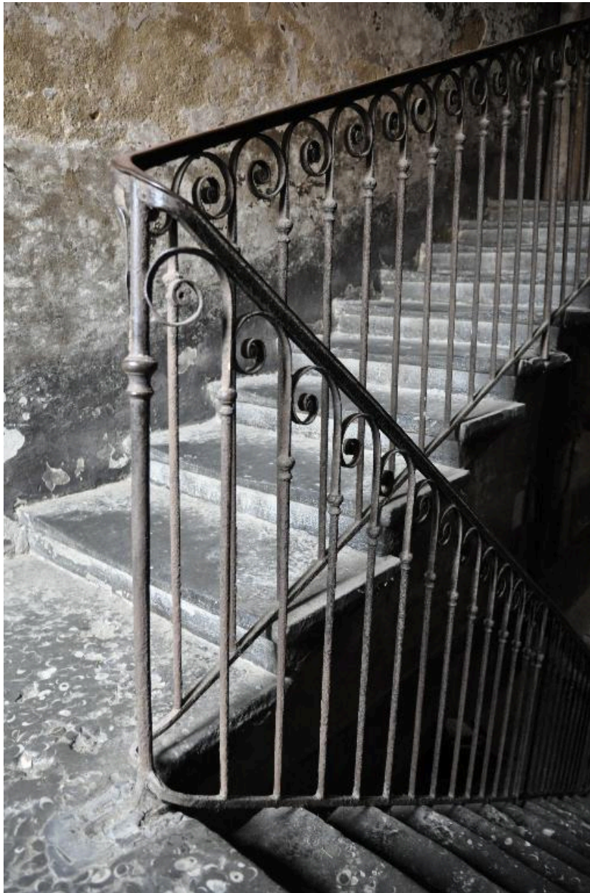
Détail de la rampe d'escalier
