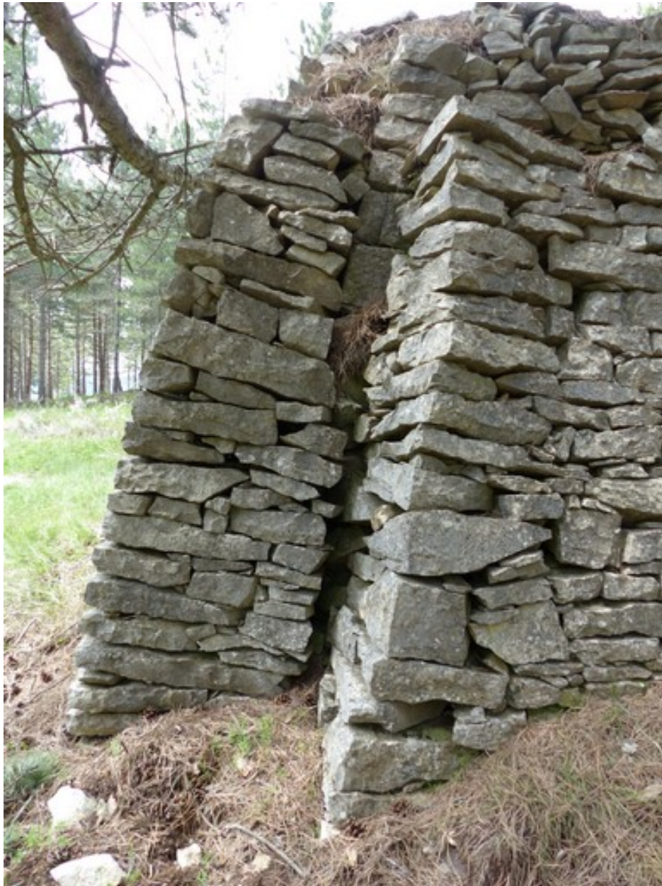
Collage d'un contrefort sur une maçonnerie en pierre sèche. Bergerie au quartier des Plaines.
