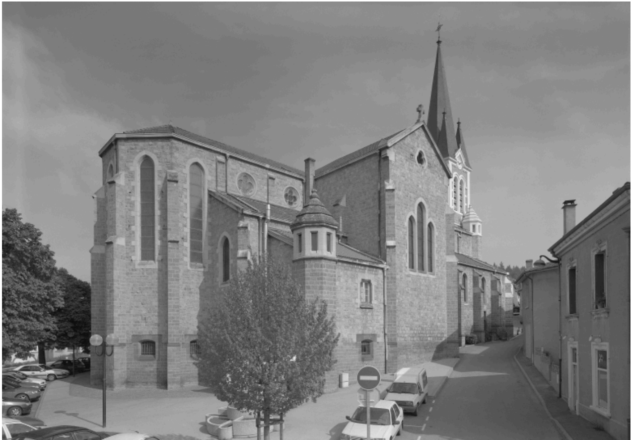
Vue générale depuis le sud.
