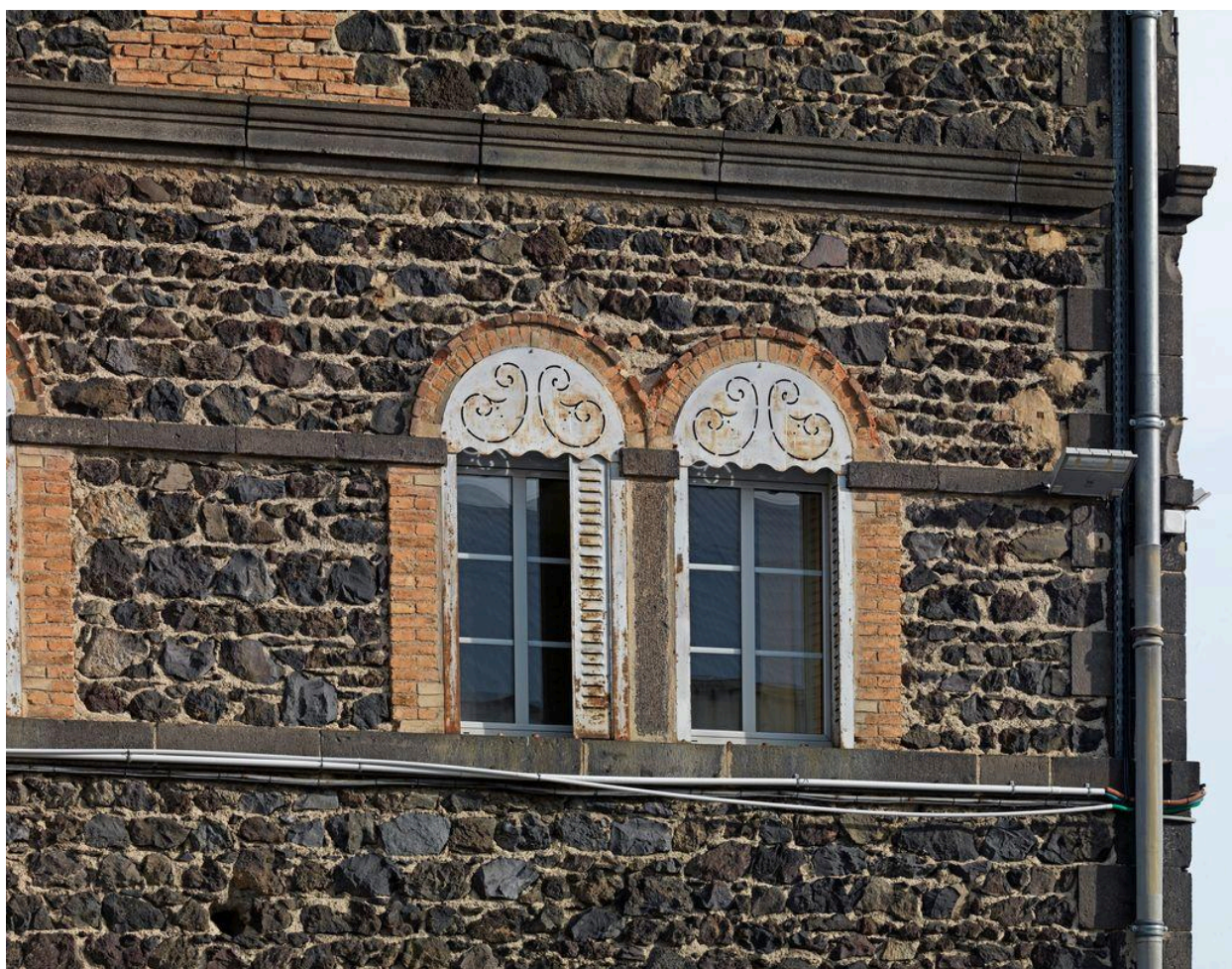
Détail baies et matériaux de construction
