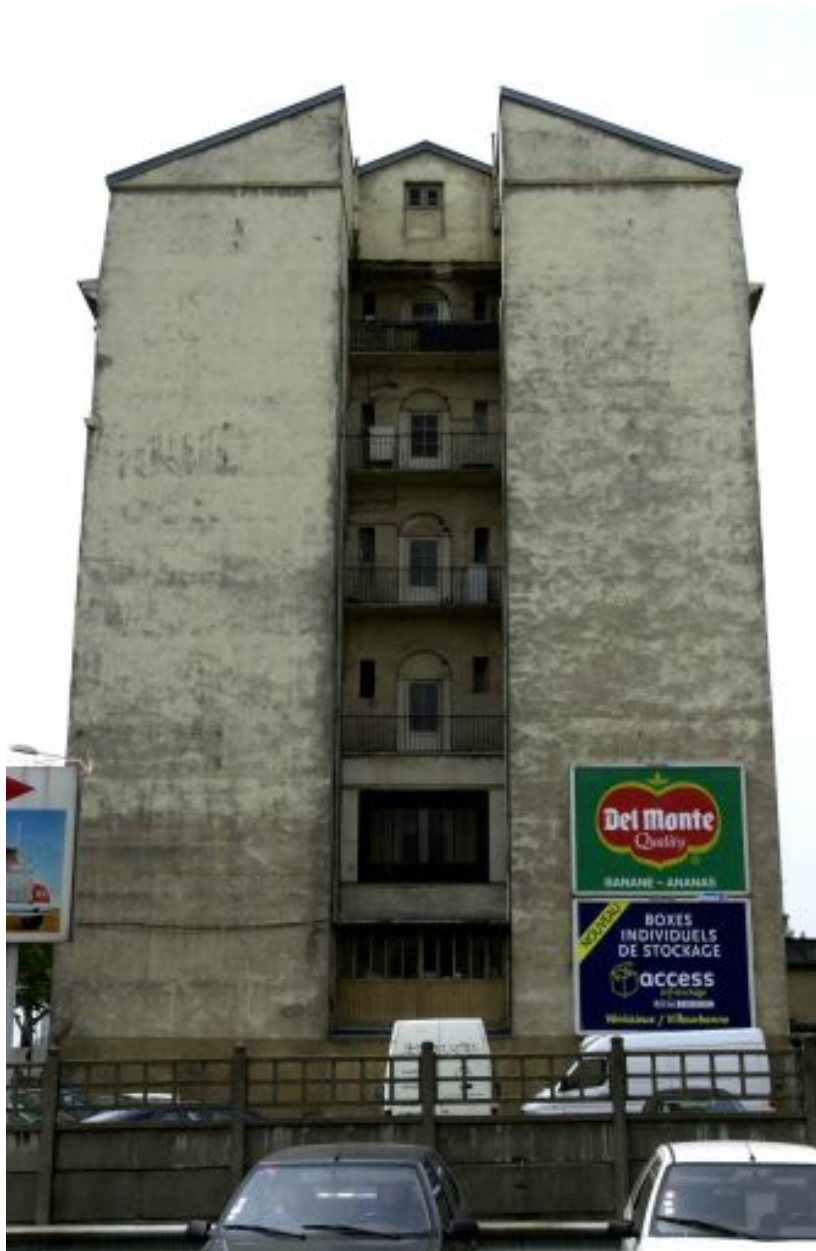
Vue du pignon nord et des coursières intérieures
