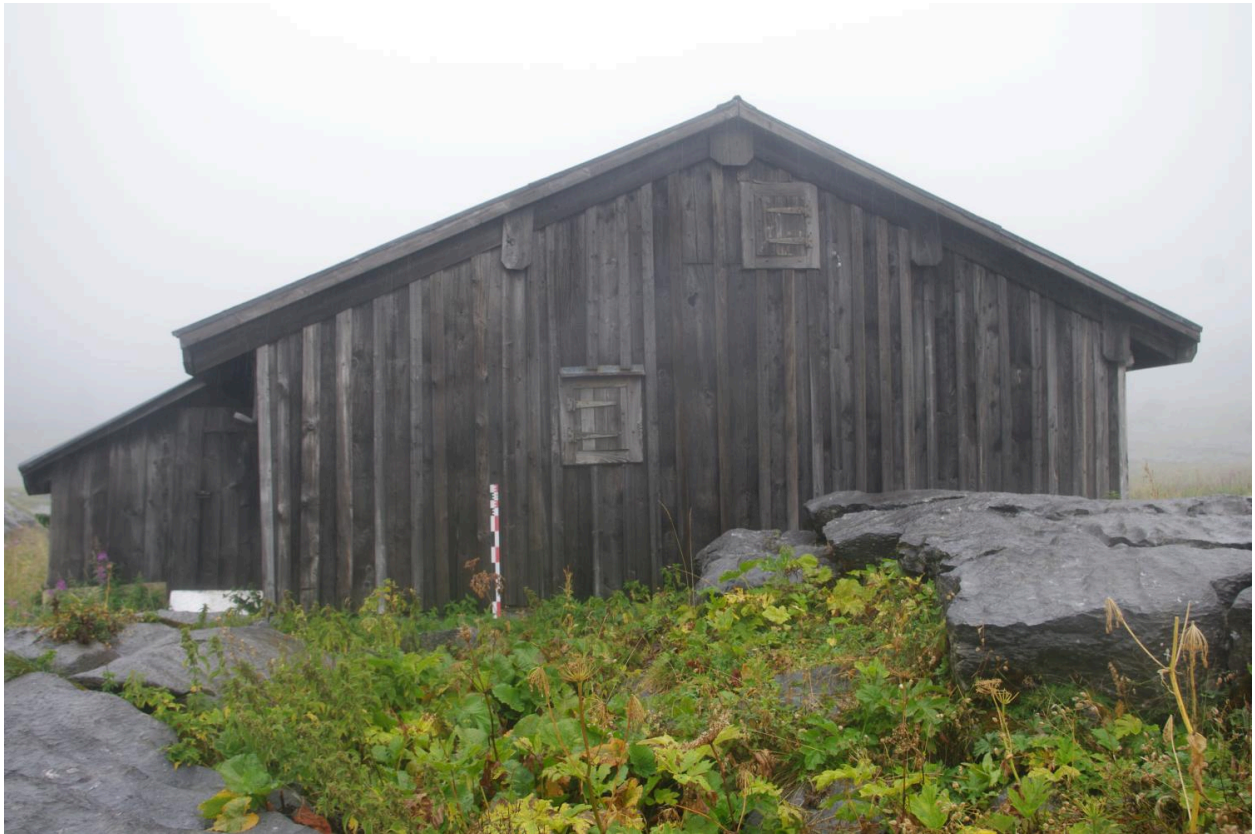
Vue du mur pignon sud
