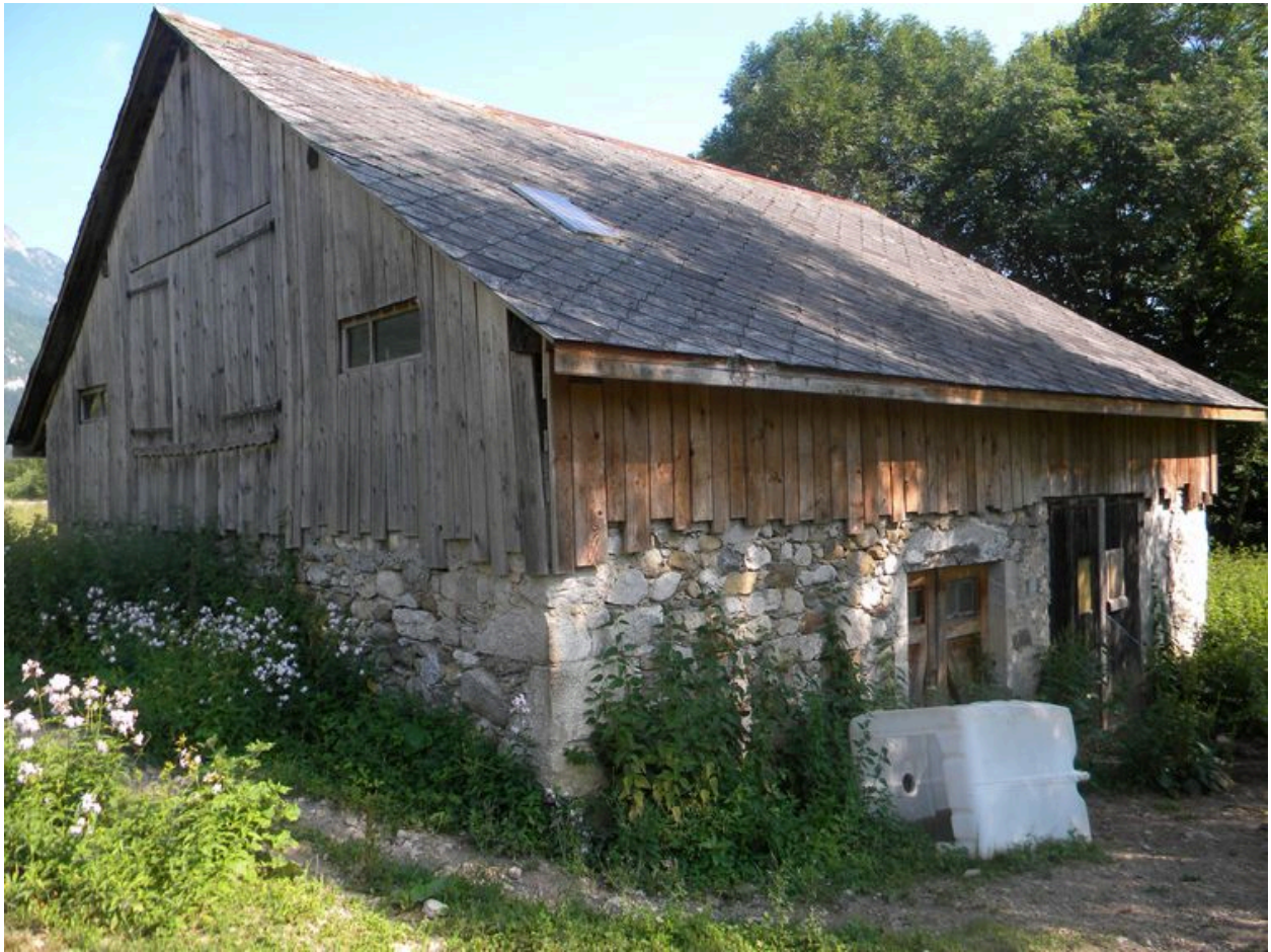
Vue de trois-quart d'une grange isolée au Jourdy (2008 A1 1152, 1153).
