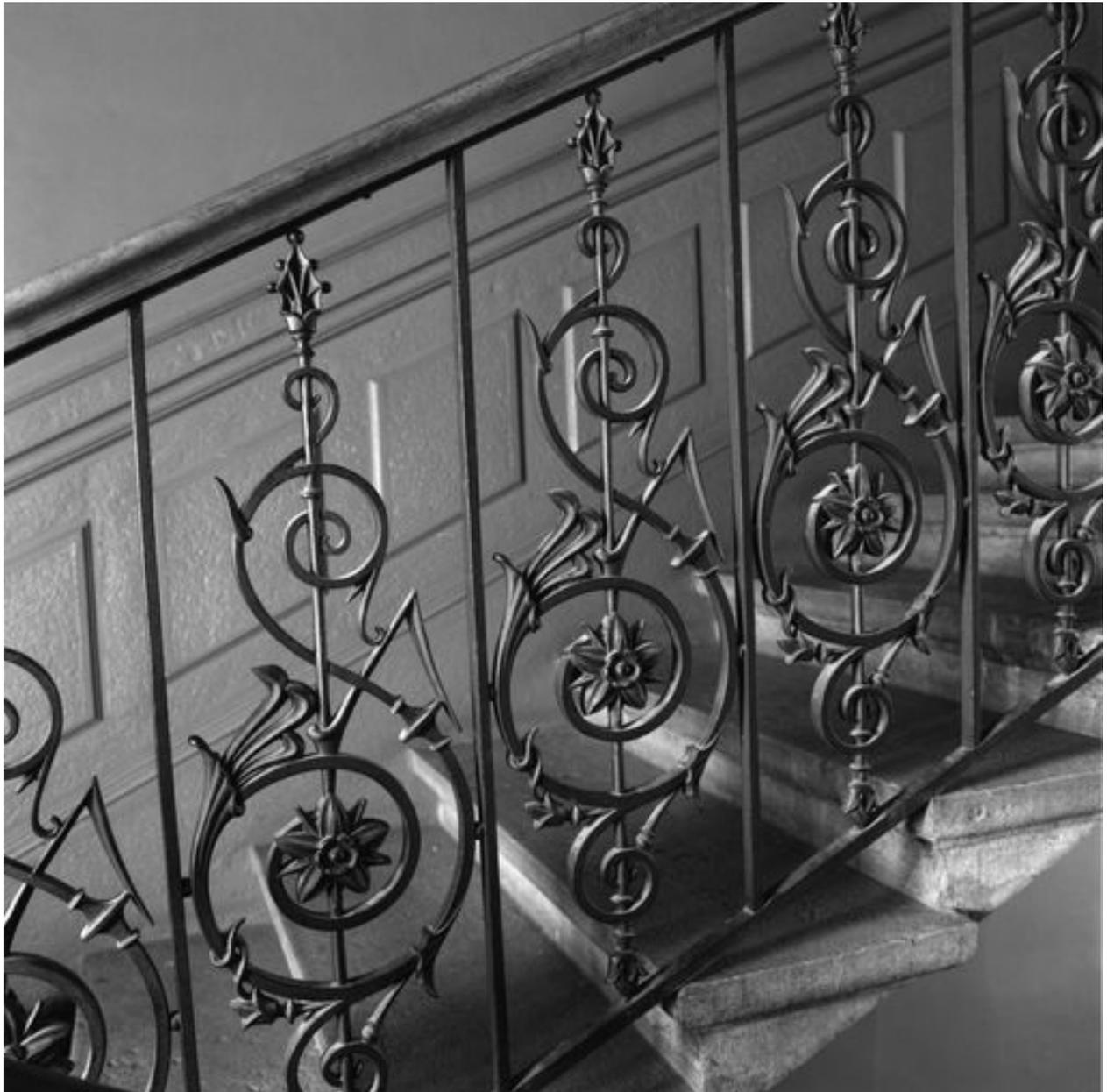
Escalier : détail de la rampe en fer forgé
