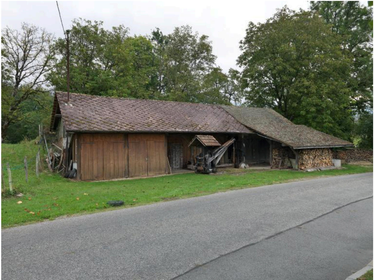
Vue de la façade ouest.
