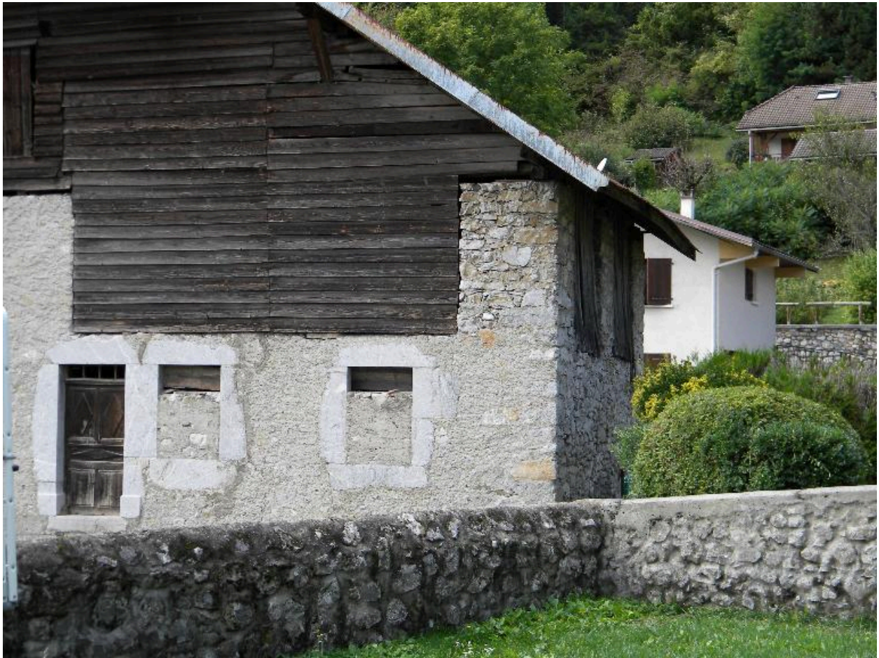
Détail des anciennes ouvertures du logis en façade est.
