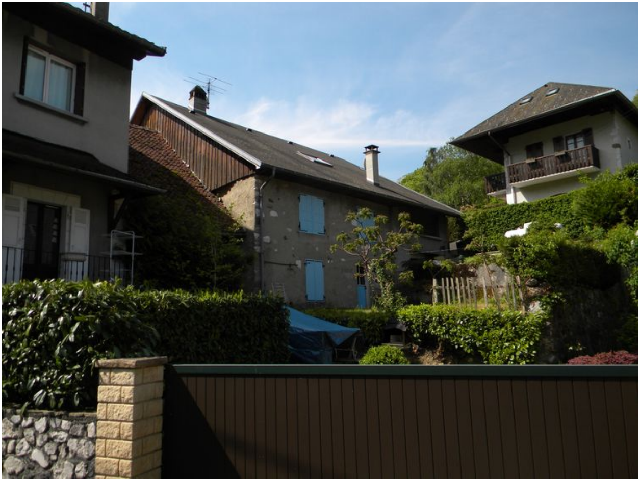
Vue de la façade arrière depuis le chemin des Lanches.
