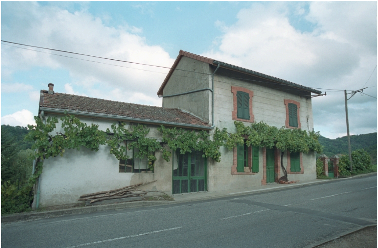
Au Bourg, vue d'ensemble de la façade avant sur rue.
