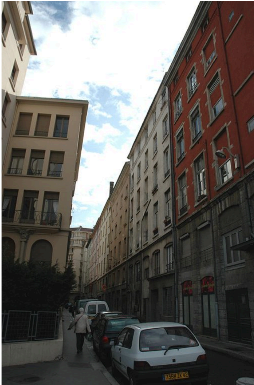
Vue de la rue de Savoie vers l'est
