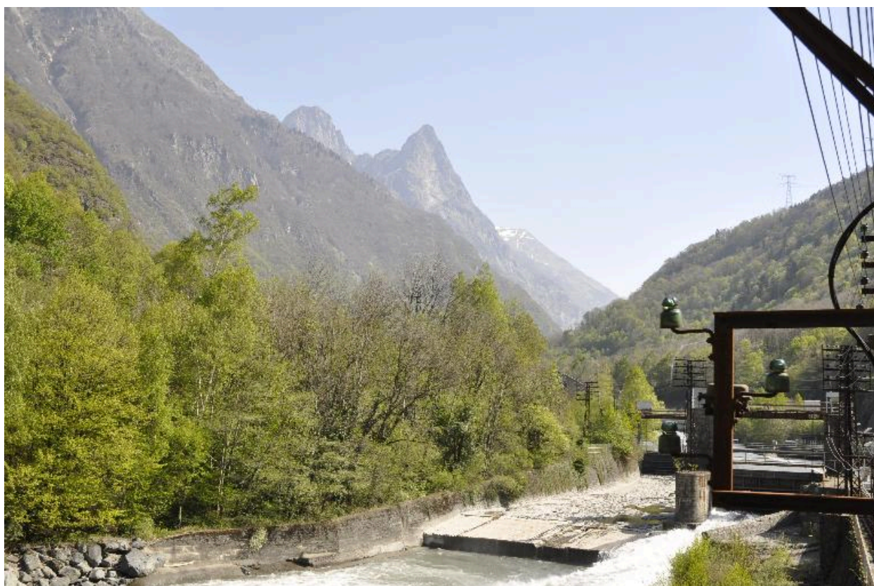
Vue du barrage de Rioupéroux
