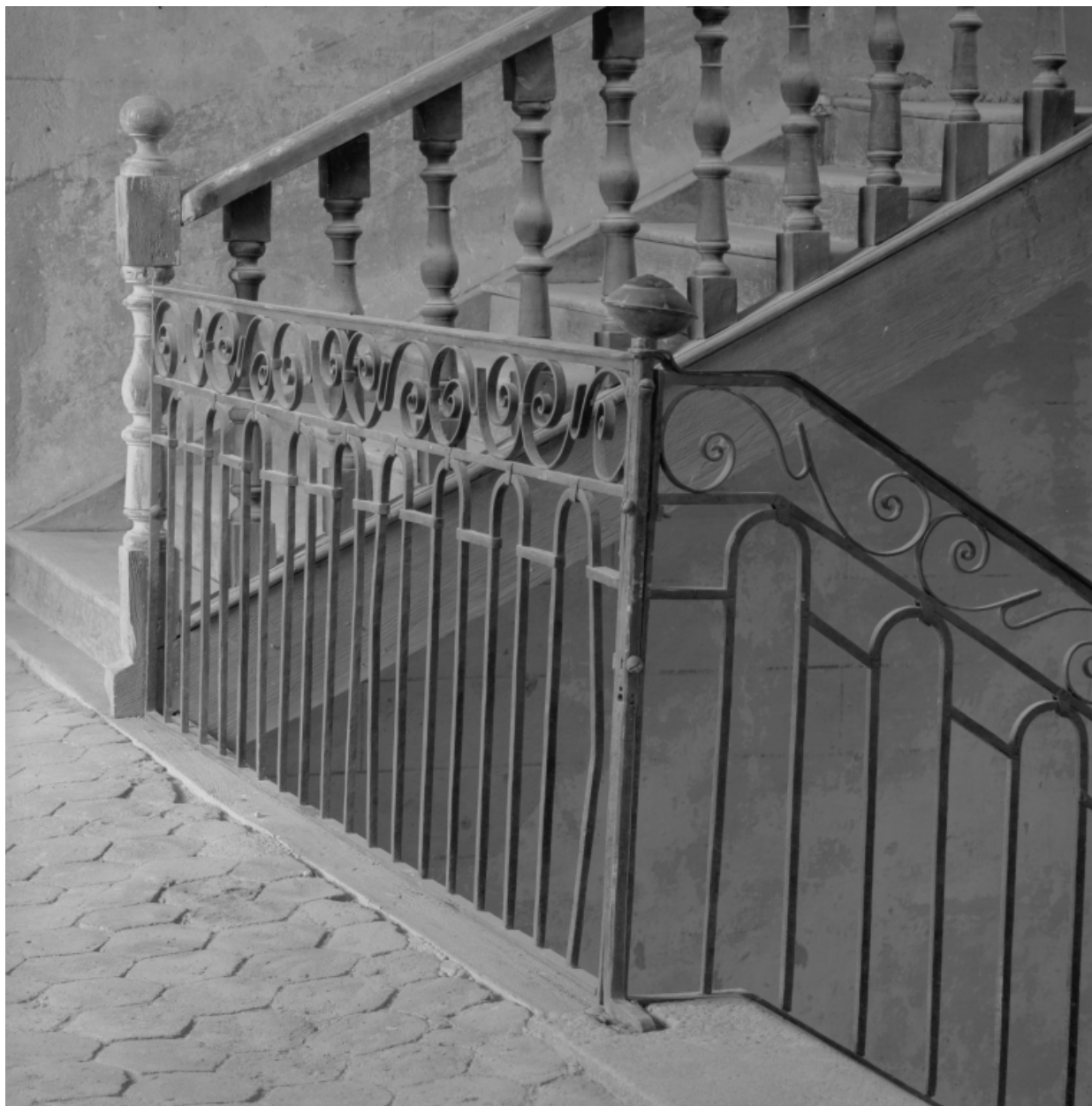
Détail de la rampe d'escalier au niveau du palier du premier étage.
